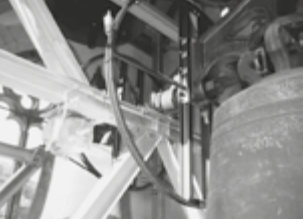
Ein Läutantrieb besteht aus dem Antriebsmotor, der Läutmaschine bzw. dem Steuerschalter und dem Antriebsrad mit Kette.
