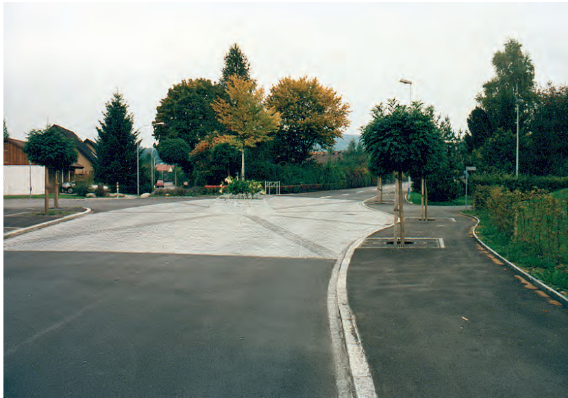
Eingangspforte mit Mittelinsel und Pflasterung
