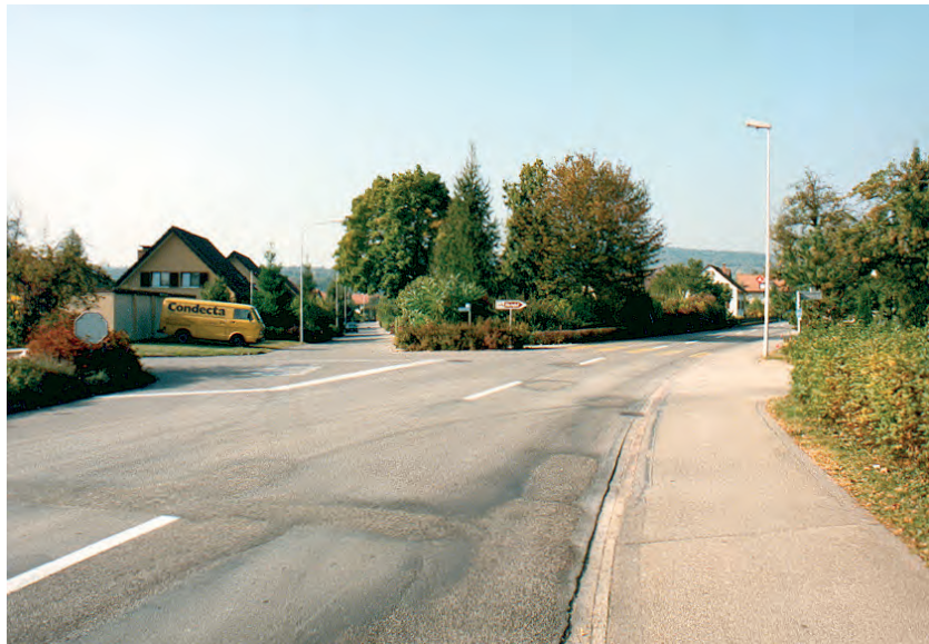
Dorfeinfahrt mit unübersichtlicher Einmündung
