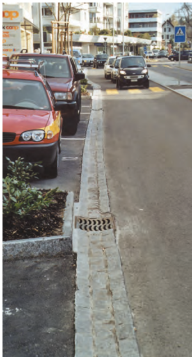
Längsparkierfelder im Zentrumsbereich
