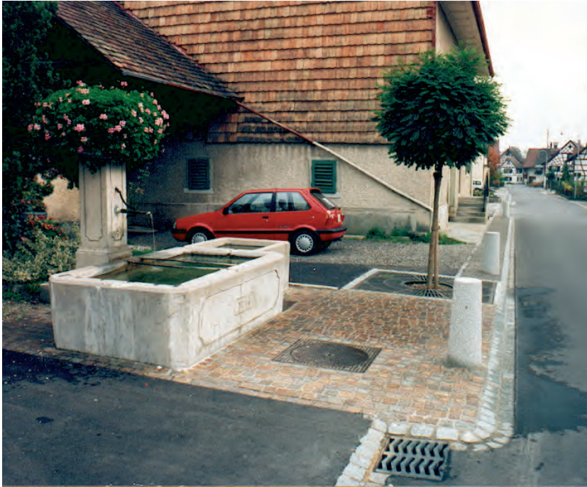
Dachsen (ZH): Fahrbahnverengung bei Brunnenplatz
