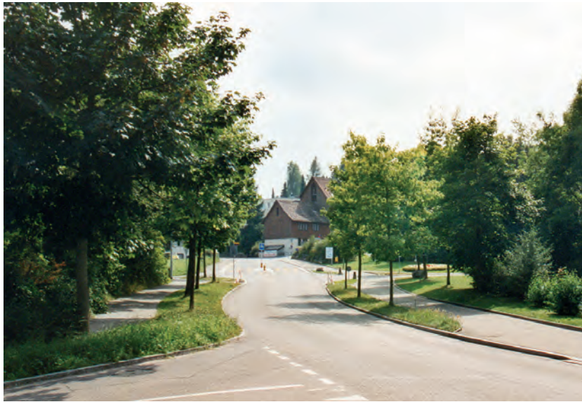
zusätzliche Mittelinsel bei Fussgängerquerung
