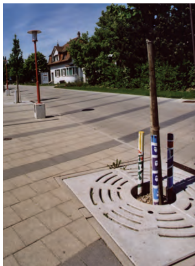
Betonelemente und Metallrost
