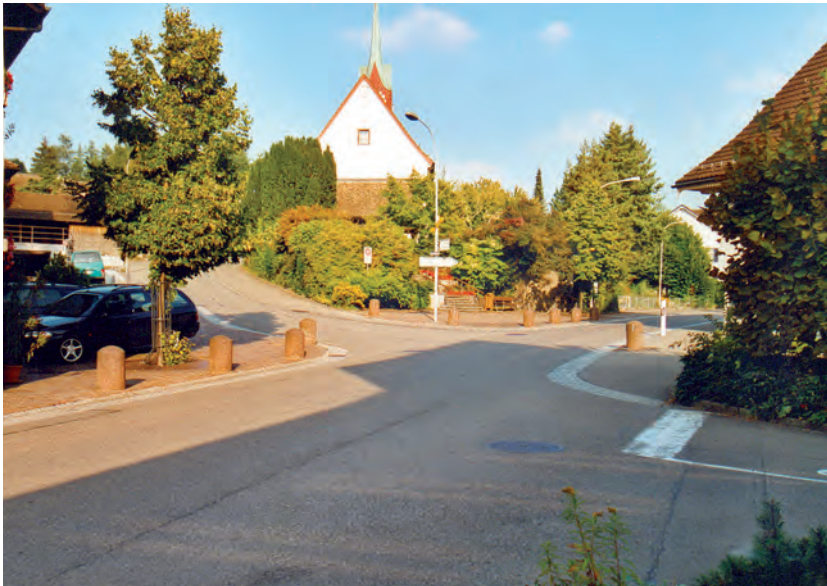
redimensionierte Einmündung, geschützt mit Wehrsteinen
