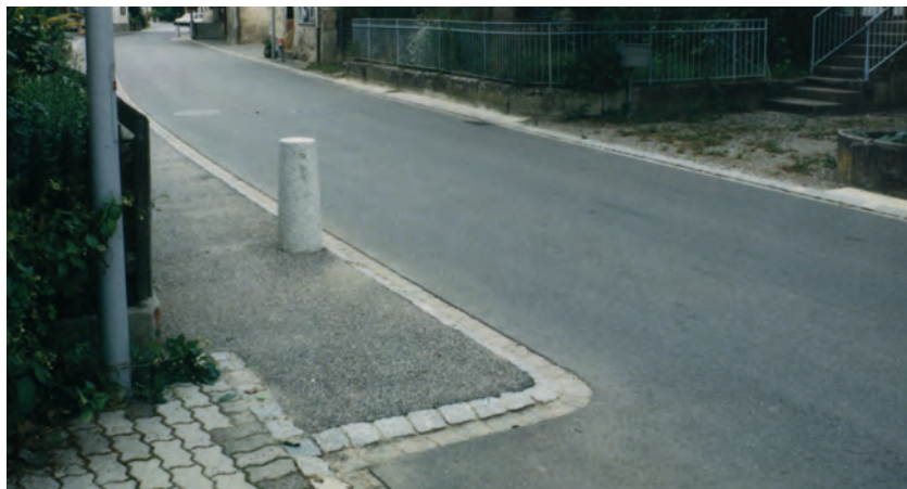
Fahrbahnverengung mit Wehrstein
