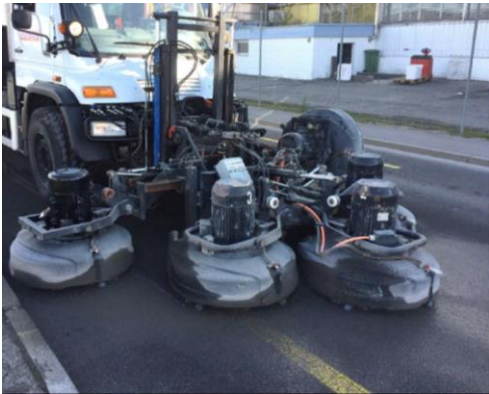
Abbildung 25: Fräsen von SDA Belägen (Quelle: Hans Weibel AG)
