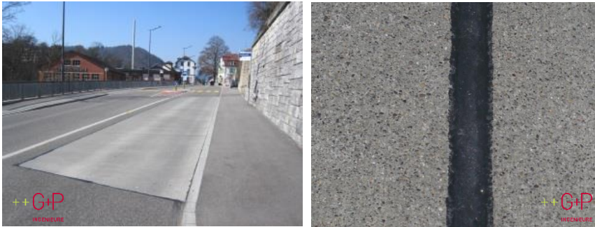
Abbildung 20: Betonelemente an einer Bushaltestelle (links) und Nahaufnahme einer Fuge zwischen zwei lärm-optimierten Betonelementen (rechts)
