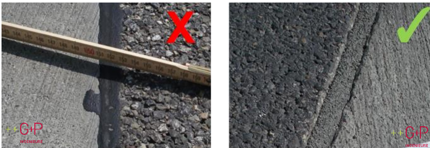
Abbildung 20: Betonelemente an einer Bushaltestelle (links) und Nahaufnahme einer Fuge zwischen zwei lärm-optimierten Betonelementen (rechts)
