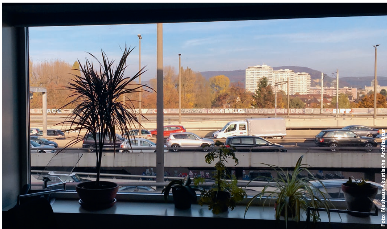
Grosse Fensterflächen können als Membrane wirken und tieffrequenten Schall in die Innenräume übertragen.
