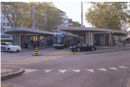
Sur la place de la Limmat à Zurich, des cylindres en acier et en verre atténuent les vibrations de basse fréquence des camions et des tramways et contribuent ainsi à plus de tranquillité.
