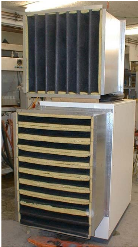
Bild E.3 Wärmepumpe mit Schalldämpfer
